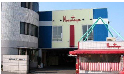
鳴門屋製パン工場
